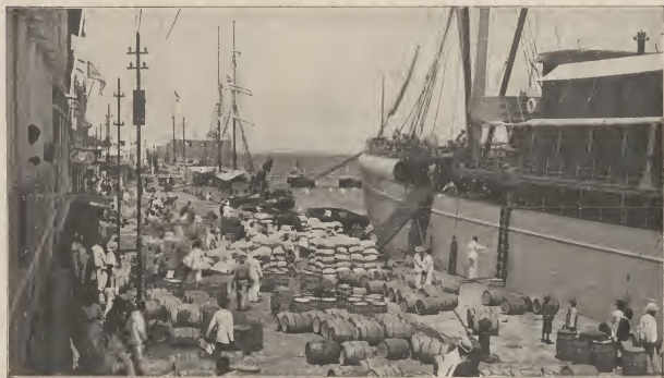
134. LOSSENDE SCHEPEN AAN DE HANDELSKADE TE WILLEMSTAD
